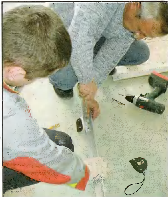
Установка петель с помощью крепежа, включённого в комплект деталей.
