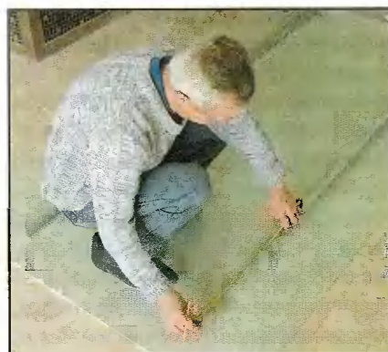
Разметка отверстий для крепления петель.
