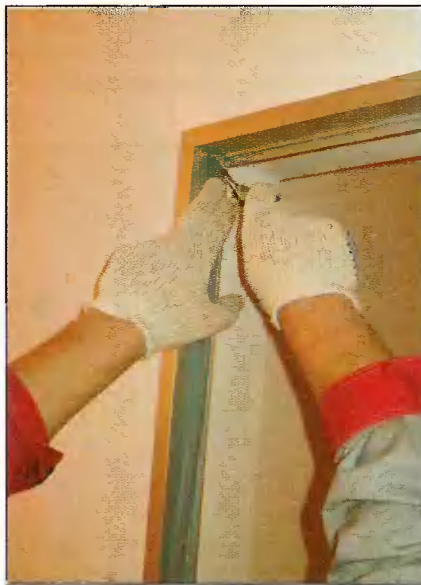
Завершающим этапом работы является монтаж резинового профиля.
