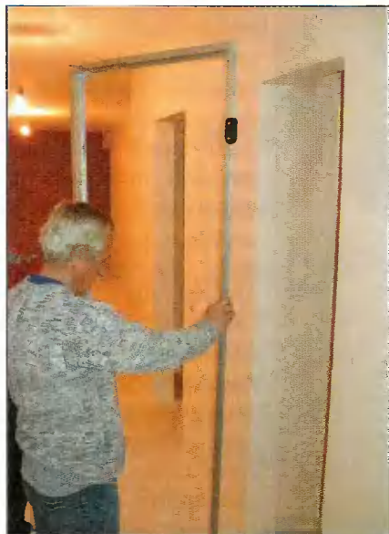
Подгонка размеров коробки под дверной проём.
