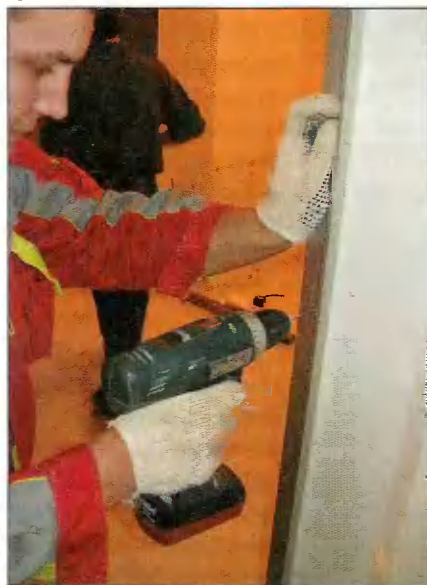
Крепление дверной коробки в проёме с помощью специальных втулок и шурупов.
