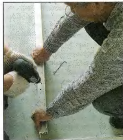
Сверление отверстий под петли.
