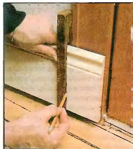
Так проводят с помощью приспособления линию запила на плинтусе.
