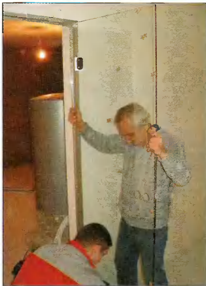
Рабочий момент установки стеклянного полотна двери.
